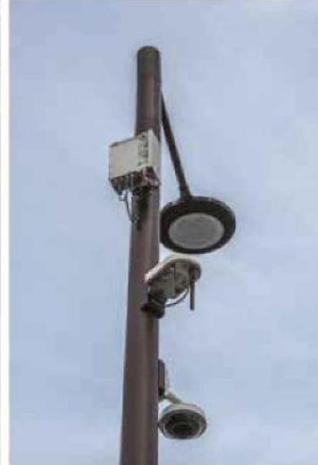
Un des neuf mâts de l'expérimentation d'infrastructure mutualisée de Paris2Connect. Dans le haut du mât, on trouve l'éclairage, une antenne 5G, une caméra de vidéoprotection... et dans le bas du mât, la connectique et les équipements qui permettent de les faire fonctionner.
